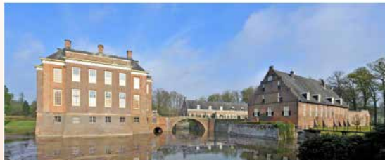
Overzicht van het kasteelcomplex vanuit het noordoorn. Links het hoofdgebouw, op de achtergrond het wervelike bovenhuis met stalen en drie recreatiewoningen, rechts het oostelijke bovenhuis met priv -tuin. Uitwet rechts de garage bij de woning. Opname 250412 (Bejn)
